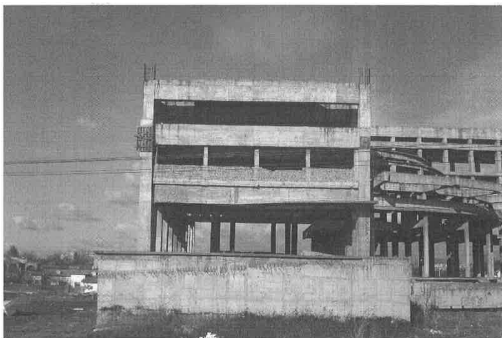
FAȚADA PRINCIPALĂ CORP A
